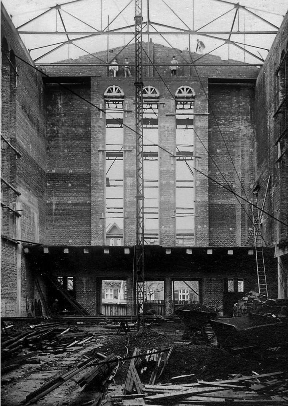
Innenansicht auf die nördliche Giebelwand mit den drei Öffnungen, die später die Fenster von Jan Thorn Prikker aufnehmen werden.
